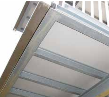
SPODNÍ KONSTRUKCE / NOSNÍKY
